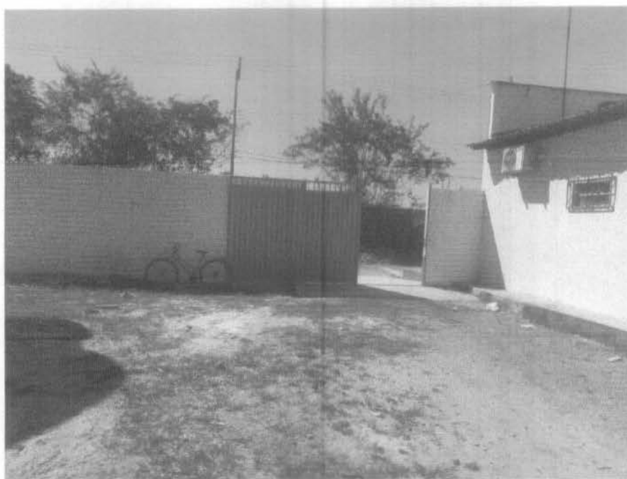
Imagem 4 – instalação de portão de metalon e barra chata de ferro com fechadura e dobradiça, incluído pintura esmalte sintético.
