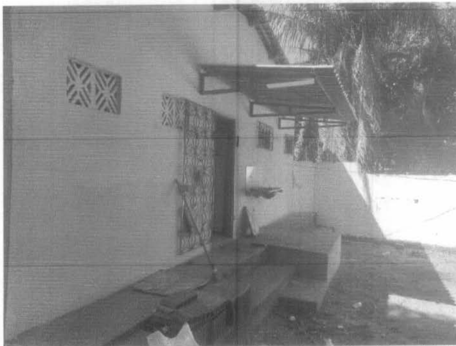
Imagem 11 – instalado cobertura da lavanderia (estrutura metálica; telha ondulada de fibrocimento, execução de passeio (calçada de concreto), pintura manual do piso da lavanderia.
