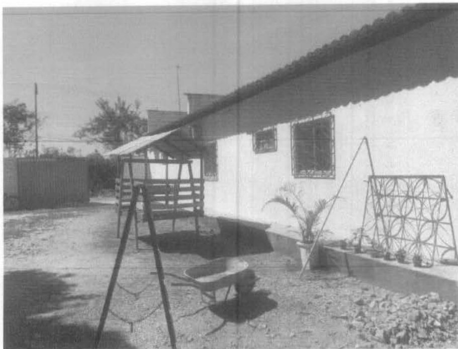
Imagem 3 – aplicação de pintura manual da área externa da pré-escola, pintura do piso de passeio.
