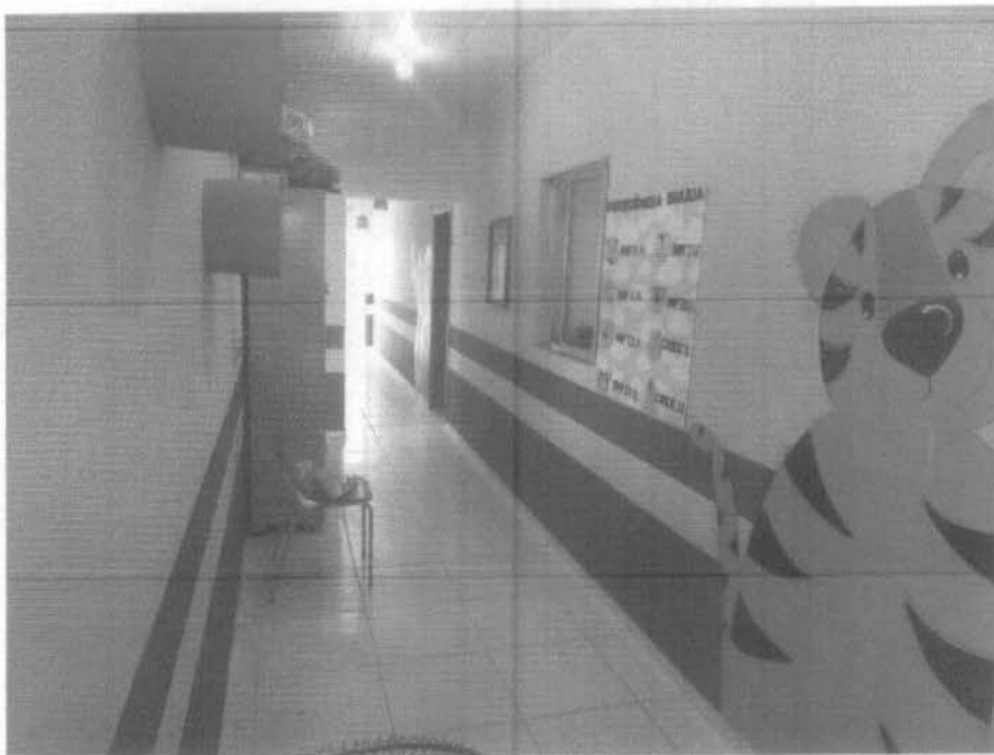
Imagem 5 – Recuperação de reboco, substituição de fechaduras completa para porta interna, instalação de alizares em madeira, pintura da área interna.
