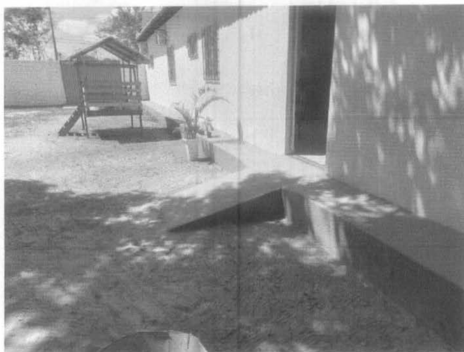
Imagem 14 – execução de rampa de acesso, aplicação de selador e pintura da área externa do prédio, recuperação da área de passeio (calçada) e pintura do piso.
