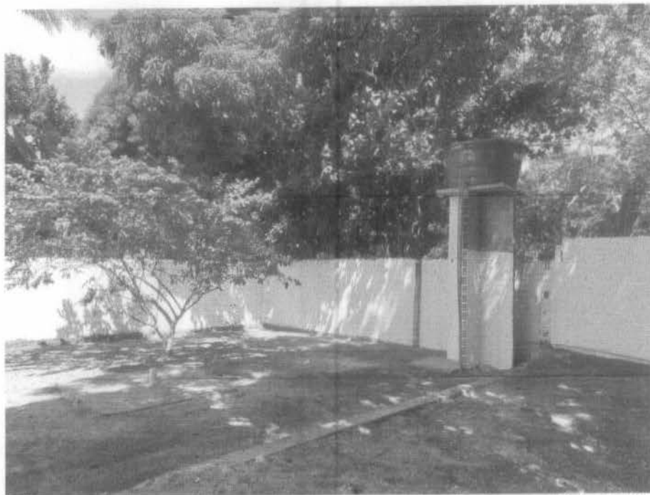
Imagem 13 – execução da base da caixa d'água, instalação do reservatório 1.000L e ponto hidráulico e distribuição de rede de água para pré-escola.
