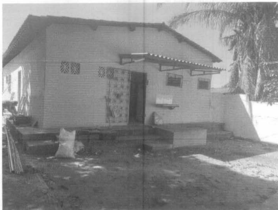
Imagem 12 – instalado cobertura da lavanderia (estrutura metálica; telha ondulada de fibrocimento, execução de passeio (calçada de concreto), pintura manual do piso da lavanderia. Recuperação da cobertura com telha cerâmica capa-canal, tipo colonial.
