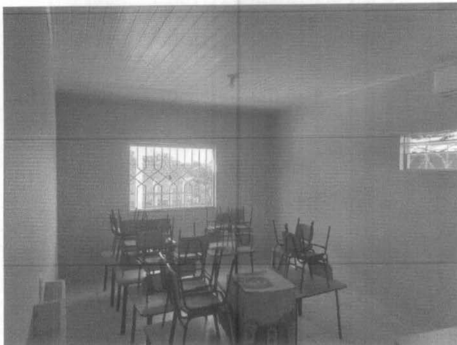
Imagem 9 – recuperação de reboco, aplicação de lixamento de massa, aplicação manual de selador e pintura com tinta acrílica em paredes, duas demãos.
