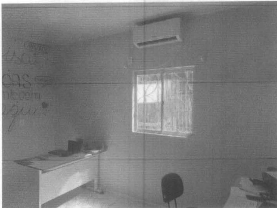
Imagem 7 – recuperação de reboco, aplicação de lixamento de massa, aplicação manual de selador e pintura com tinta acrílica em paredes, duas demãos
