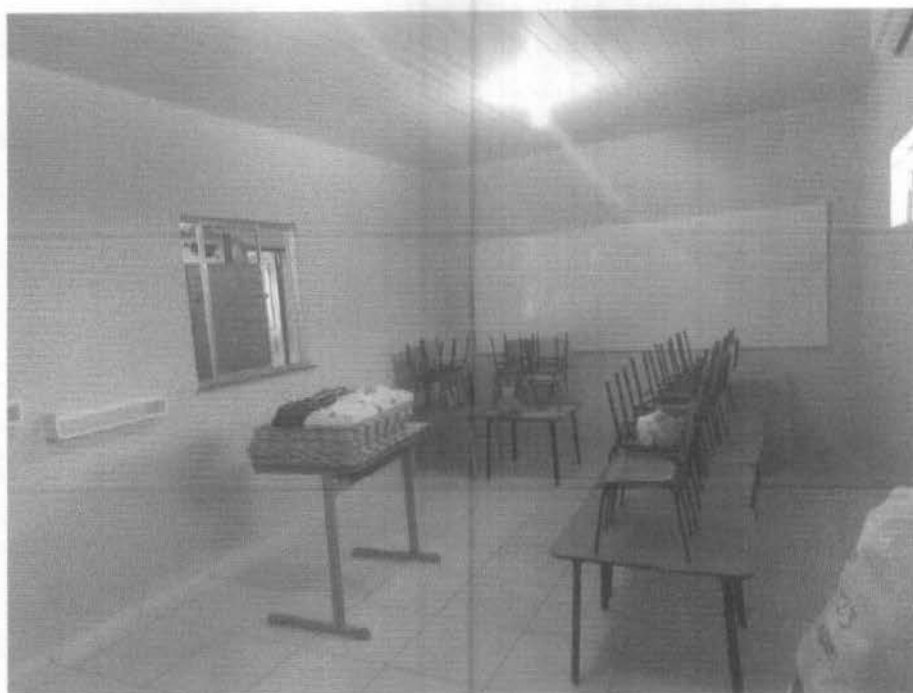
Imagem 8 – recuperação de reboco, aplicação de lixamento de massa, aplicação manual de selador e pintura com tinta acrílica em paredes, duas demãos
