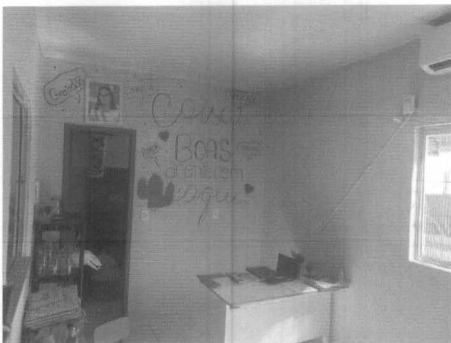
Imagem 6 – Recuperação de reboco, substituição de fechaduras completa para porta interna, instalação de alizares em madeira
