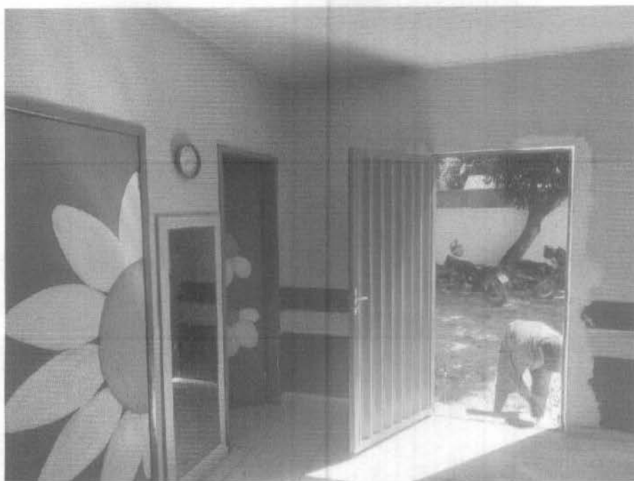
Imagem 10 – execução de porta de ferro de abrir tipo grade com chapa, pintura das esquadrias.
